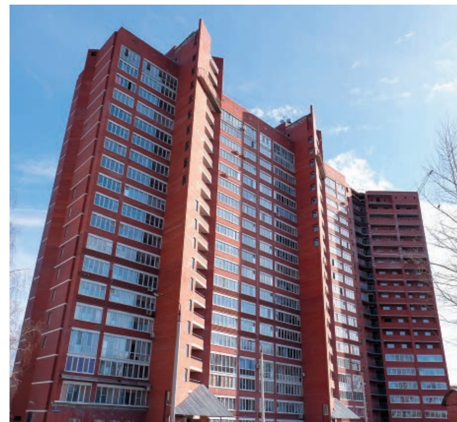
Достраиваемый с помощью мер поддержки жилой дом по ул. Челюскинцев, 23
